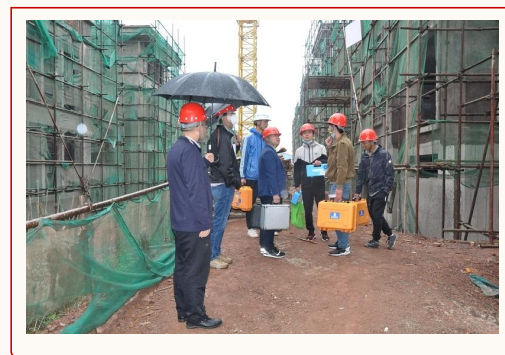
施工项目现场检测
